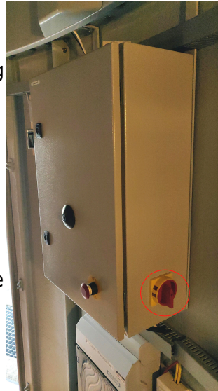
Abb. 1: Kuppelsteuerungskasten - rot: Hauptschalter
